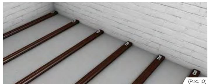
Для этого смонтируйте стартовые клипсы на край каждой лаги вдоль стены в начале предполагаемого настила. (Рис.11)
