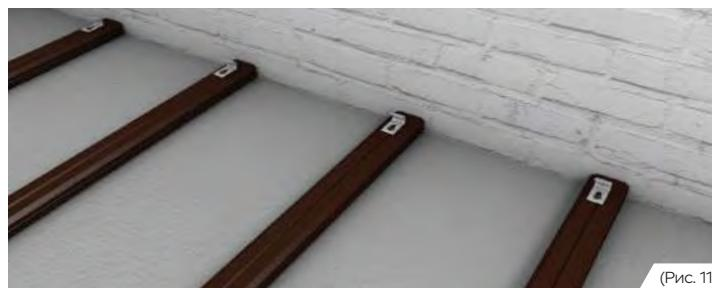
Первая доска задвигается в паз стартовой клипсы до упора. В некоторых случаях, в особенности при монтаже в холодную погоду (**ниже 0°C**), требуется предварительное просверливание несущих лаг перед окончательной фиксацией клипсы. Для более плотной и равномерной фиксации доски используйте киянку.
