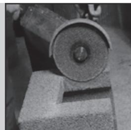
20. Угловой шлифовальной машиной вырежьте отверстие.
