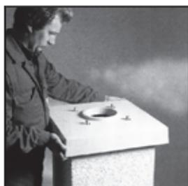
41. Положите покровную плиты проверьте уровнем.
